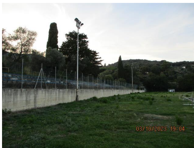
FOTO N. 4 – Muro in C.A. e Torri Faro esistenti
