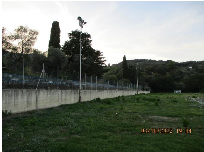
FOTO N. 5 – Muro in C.A. e Torri Faro esistenti
